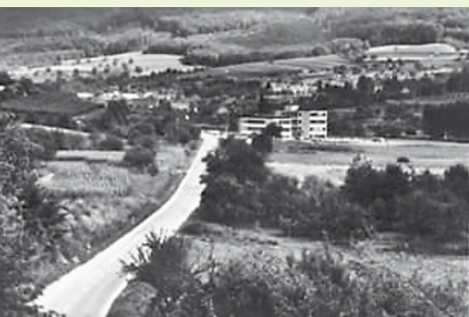
Broggingen mit neuen Fallergebäuden
